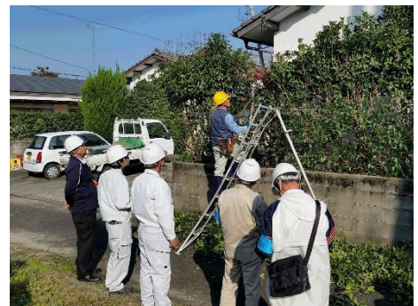
安全パトロールの様子
